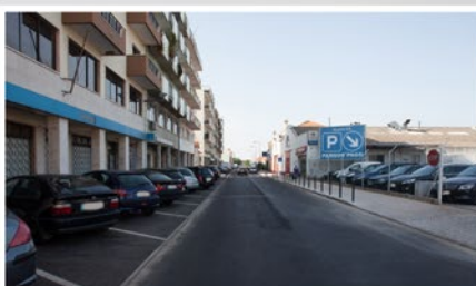
Requalificação da Rua Joaquim Pedro Monteiro
